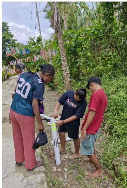
Gambar 3. Pemasangan Reflektor Jalan
